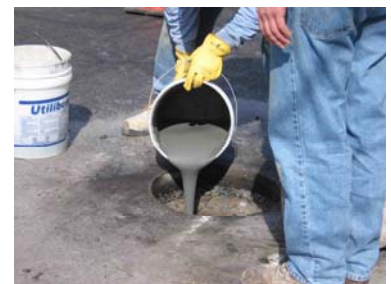
9. Pouring Utilibond in the hole
